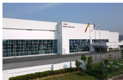
マレーシア第二工場
