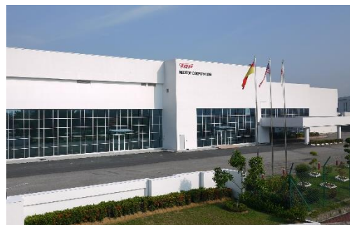
マレーシア第二工場
