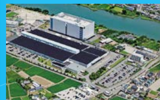
鳴門工場 (N工場)
