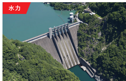
佐久間発電所(静岡県)
