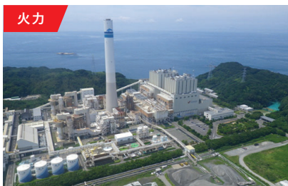
松島火力発電所(長崎県)
