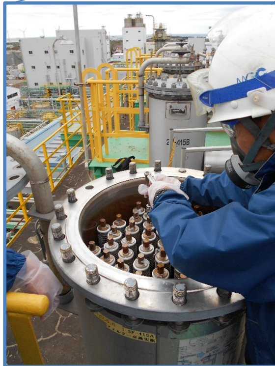
現場作業の確認
