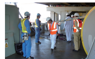
陸上電力供給設備へのケーブル接続作業 Cable connection work to shore power from onboard AMP system
