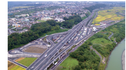
厚木PAスマートインターチェンジ [神奈川県]
