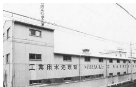
本社工場 (1968年頃に 建設した本社工場の外観)
