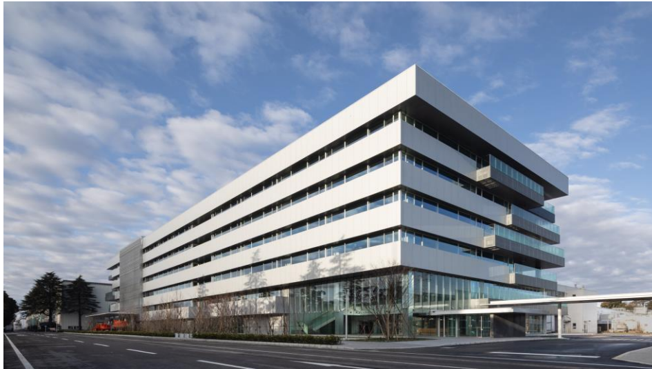
エンジニアリング棟 Orange Innovation Plaza 2023年5月～
