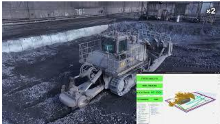
ブルドーザーによるスラグ破碎作業自動化
