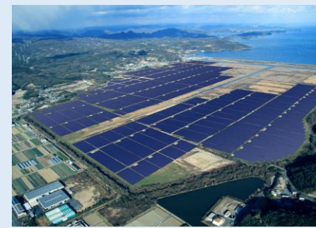
再エネ発電所
