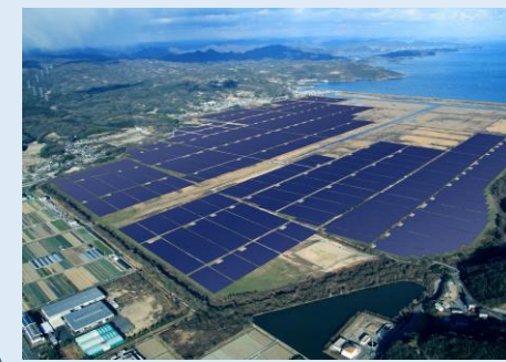
再エネ発電所
