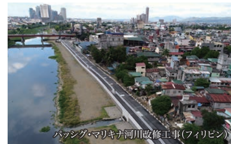
マニラ首都圏における洪水対策として、護岸整備、河道浚渫、堰・水門を施工 (ODA・円借款工事)
