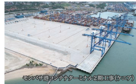
モンバサ港コンテナターミナル2期工事(ケニア) 1期に続き2期工事を施工。年間取扱能力は約92万TEUから約208万TEUへ向上 (ODA・円借款工事)
