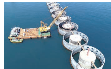
兵庫県北部の柴山港において防波堤本体の性能を維持するための補修工事を施工
