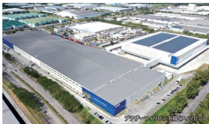
バタンガス州・FPIP工業団地において、第1、第2工場に続き第3工場を施工し、延床面積20万㎡を超える大型のプリンター製造工場が誕生
