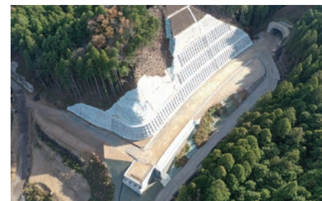
愛知県北東部の設楽ダム建設工事の一環として道路の法面保護及び橋台工事を施工
