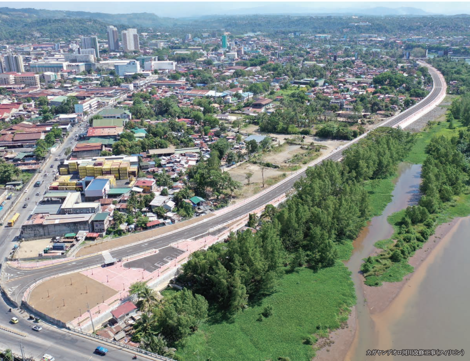
カガヤンデオロ市における洪水対策工事として、カガヤンデオロ川の河川敷に2.3kmの洪水擁壁(2車線道路併設)を施工 (ODA・円借款工事)
