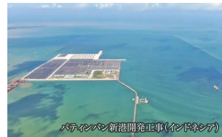
パテインバン新港開発工事(インドネシア) 西ジャワ州における新国際港建設の一環で、外周護岸、防波堤、浚渫工事を施工 (ODA・円借款工事)
