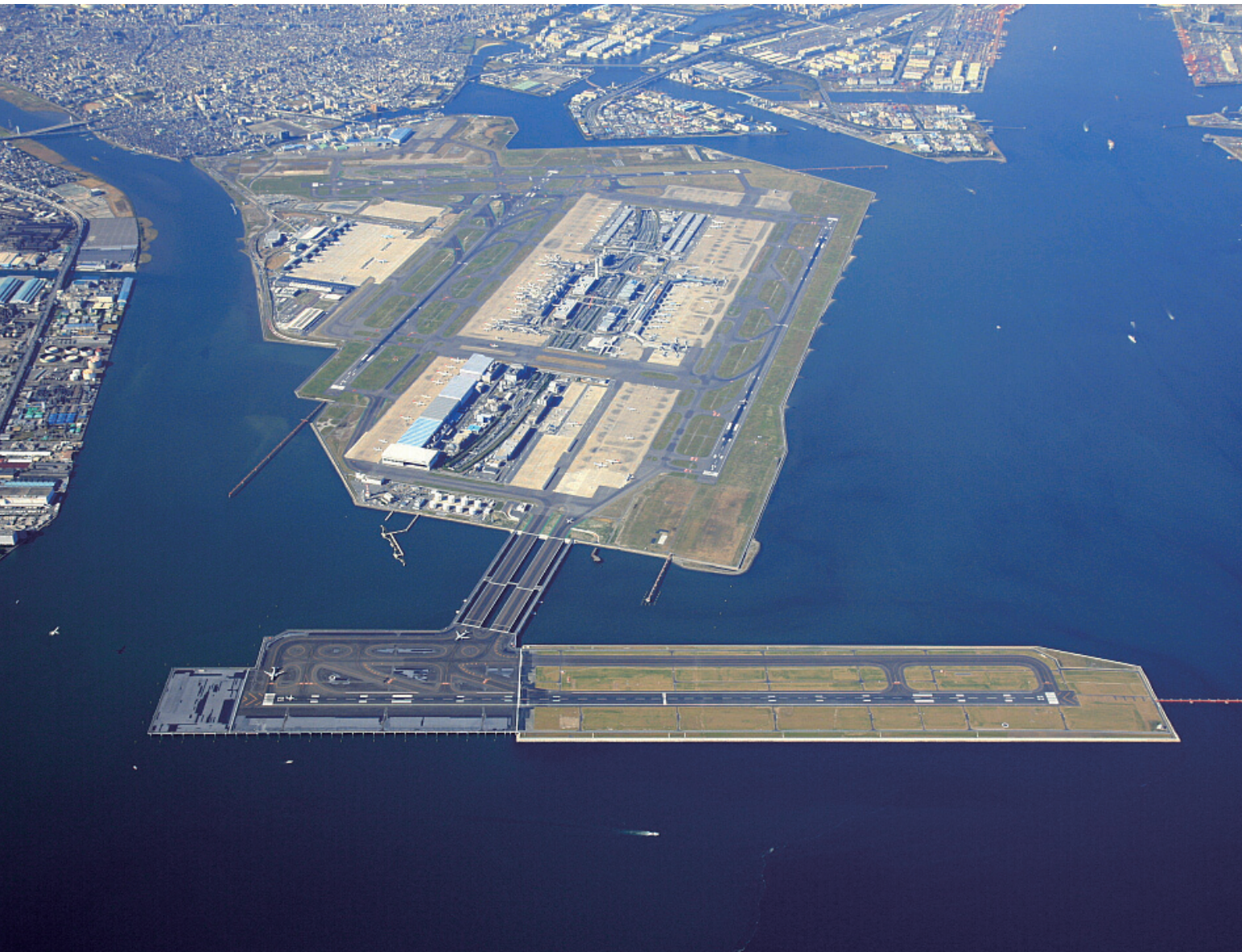
東京国際空港のD滑走路建設工事において、基礎工事から滑走路完成まで一連の工事を施工（写真手前側がD滑走路）
