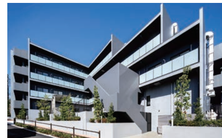
プレザンメゾン板橋徳丸（福祉施設）
