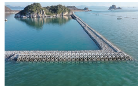
熊本県八代港の大築島において土砂処分場の護岸築造工事を施工
