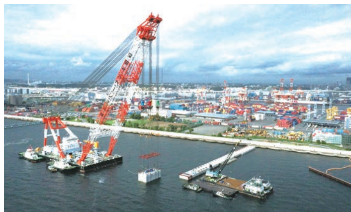
神奈川県横浜港に建設中の新本牧ふ頭において世界規模のコンテナ船が着岸できる護岸築造工事を施工
