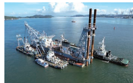
瀬戸内海の備讃瀬戸水島航路交差点においてポンプ浚渫船による航路の維持浚渫工事を施工
