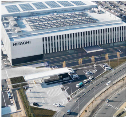
笠戸地区屋上の太陽光発電パネル
