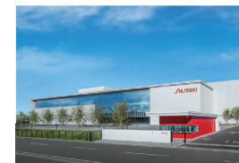
資生堂久留米工場生産設備 (2022年竣工)
