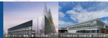
某データセンター新築工事 (2022年竣工)
