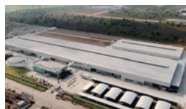
タイ住宅生産工場
