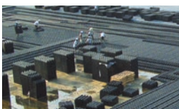
雨水貯留・浸透槽
