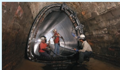
米国での管路更生工事の様様
