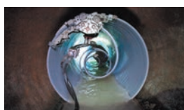
下水道管路更生工法
