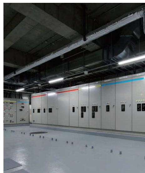
電気設備（特高受変電設備）
