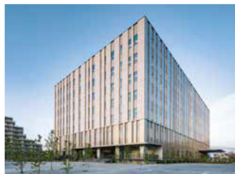
大阪貯金事務センター
