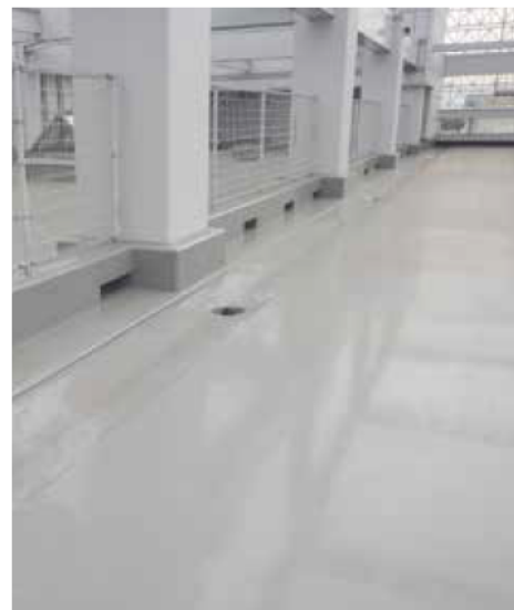
屋上防水改修工事（完成後）
