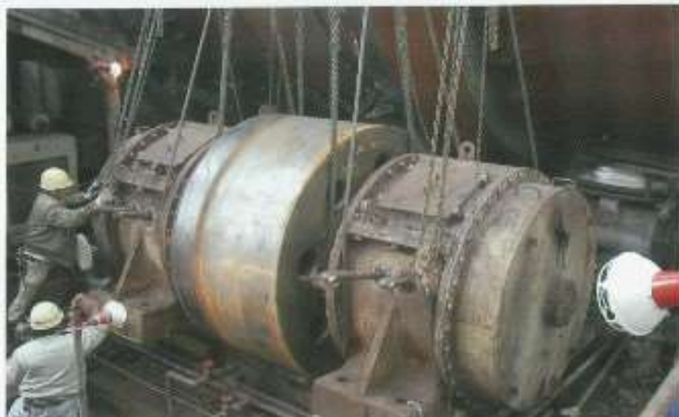
セメントキルン用サポートローラ・軸受取替
