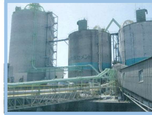
セメント受入圧送管
