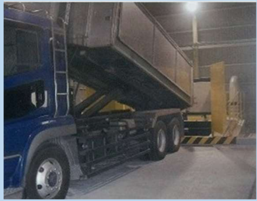
汚泥受入設備
