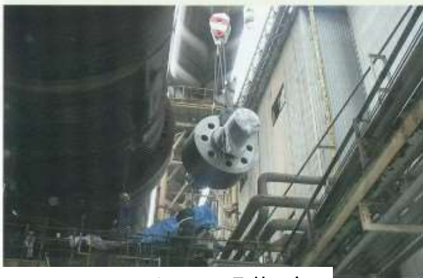
セメントキルン用サポートローラ取替工事
