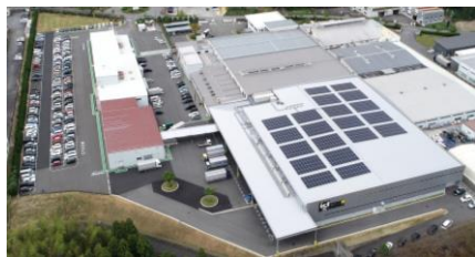
本社第一工場
