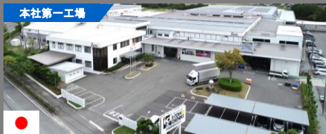
本社第一工場
