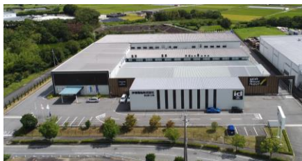
東山第二工場/イノベーションセンター
