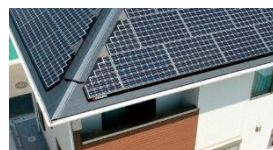
太陽光発電システム
