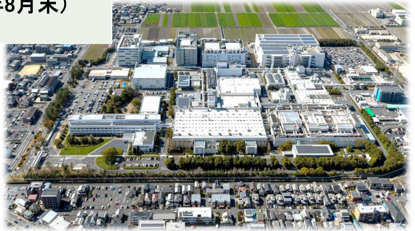
滋賀野洲工場全景
