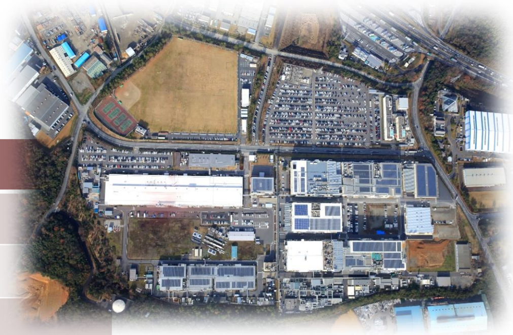
滋賀八日市工場全景
