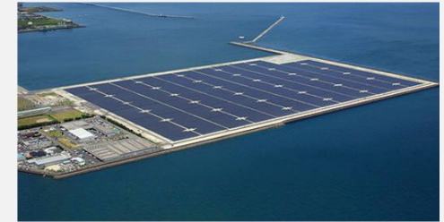
鹿児島七ツ島メガソーラー発電所
