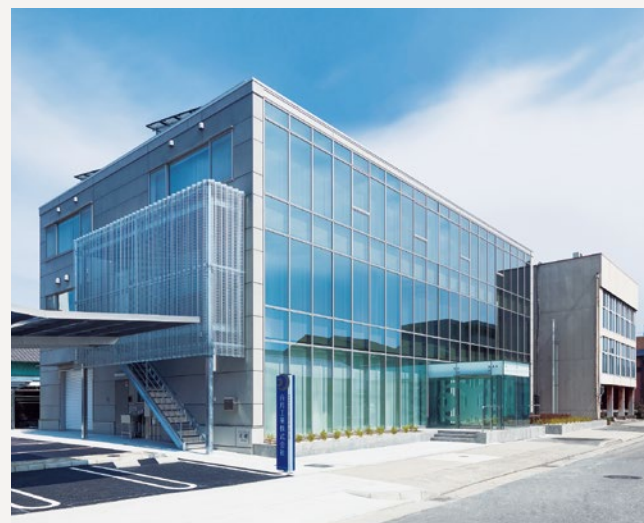
【白月工業(株) 新社屋】 S3F 建築面積:339㎡ 延床面積:996㎡ 設計:黒田設備設計事務所 竣工:2014年
