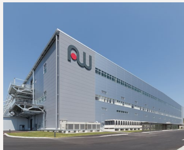
【アイシン・エイ・ダブリュ(株) 岡崎東工場】 S4F 建築面積:26,125㎡ 延床面積:70,467㎡(増築部分) 設計:アイシン開発・清水建設 竣工:2015年
