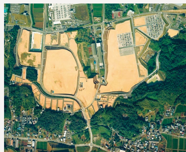
【岐阜県美濃加茂市中蜂屋工業団地造成】 美濃加茂市中蜂屋土地区画整理事業 開発面積302,840㎡ 全8区画完売 竣工:2013年
