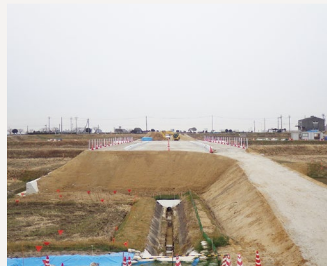
【道路築造工事(市道八橋町109号線)】 [発注者:知立市] 竣工:2018年
