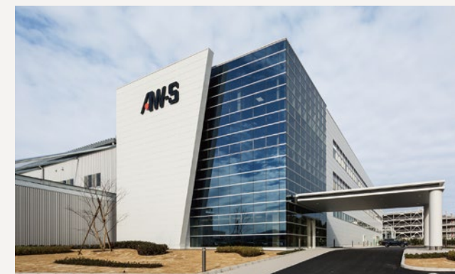
【(株)エイ・ダブリュ・サービス 岡崎物流センター】 S3F 建築面積:18,547㎡ 延床面積:35,097㎡ 設計:アイシン開発 竣工:2016年
