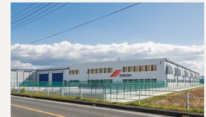
【大興運輸(株) 岡崎支店J棟】 S1F 建築面積:5,342㎡ 延床面積:5,471㎡ 設計:アイシン開発 竣工:2017年
