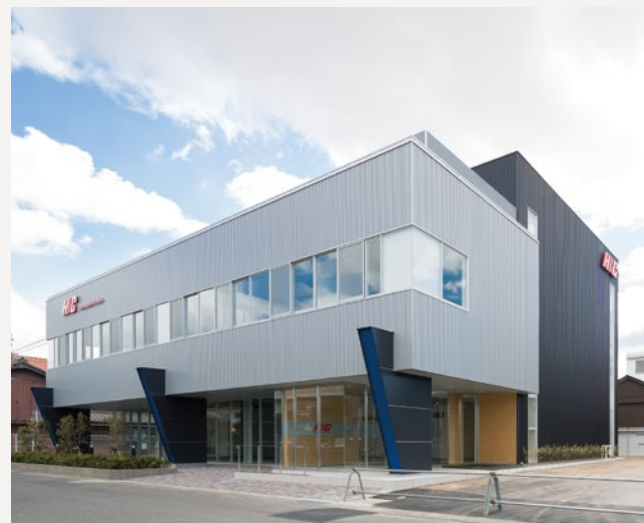
【豊安工業(株) 新事務所】 S3F 建築面積:554㎡ 延床面積:1,371㎡ 設計:アイシン開発 竣工:2017年
