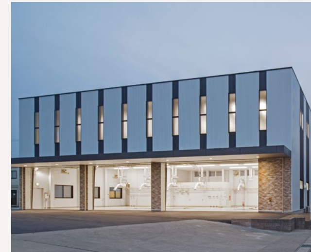
【光南工業(株) 高岡事業所 整備工場】 S2F 建築面積:399㎡ 延床面積:741㎡ 設計:アイシン開発 竣工:2018年
