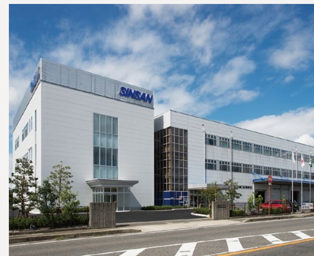
【新三商事(株) 新三工房】 S3F 建築面積:476㎡ 延床面積:1,282㎡ 設計:アイシン開発 竣工:2016年
