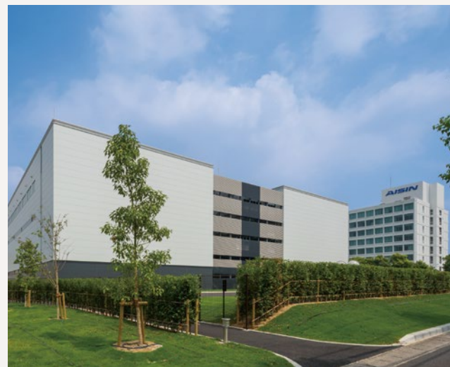
【アイシン精機(株) Vラボ】 S3F 建築面積:5,822㎡ 延床面積:17,240㎡ 設計:アイシン開発・清水建設 竣工:2017年
