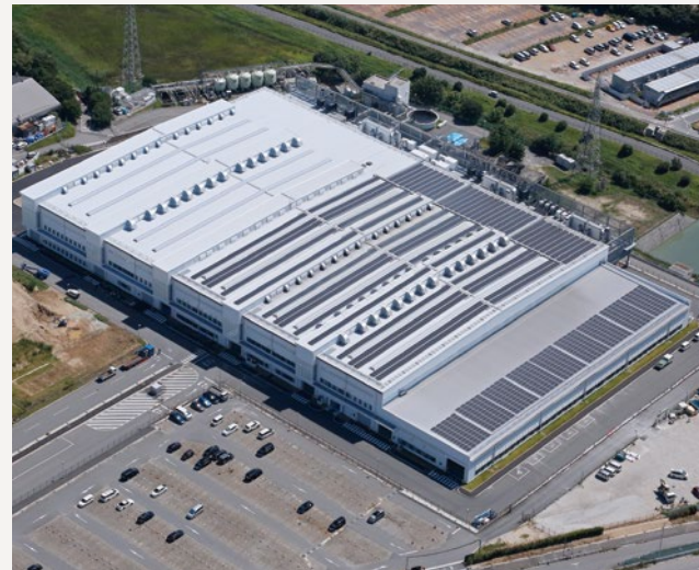
【アイシン精機(株) 西尾ダイカスト工場 南棟】 S2F 建築面積:18,897㎡ 延床面積:19,776㎡ 設計:アイシン開発・清水建設 竣工:2018年
