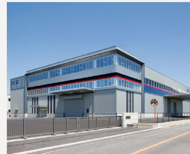
【(株)石亀工業 新工場 増築】 S3F 建築面積:475㎡ 延床面積:1,240㎡ 設計:渡辺設計 竣工:2017年
