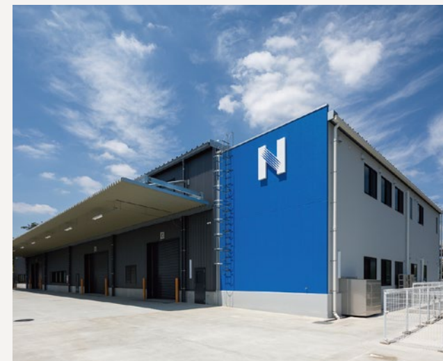
【中島特殊鋼(株) 新工場】 S一部2F 建築面積:2,920㎡ 延床面積:2,957㎡ 設計:大建設 竣工:2018年
