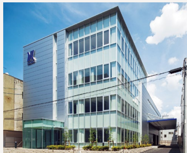
【ミズショー(株) 本社事務所】 S4F 建築面積:709㎡ 延床面積:1,820㎡ 設計:アイシン開発 竣工:2016年
