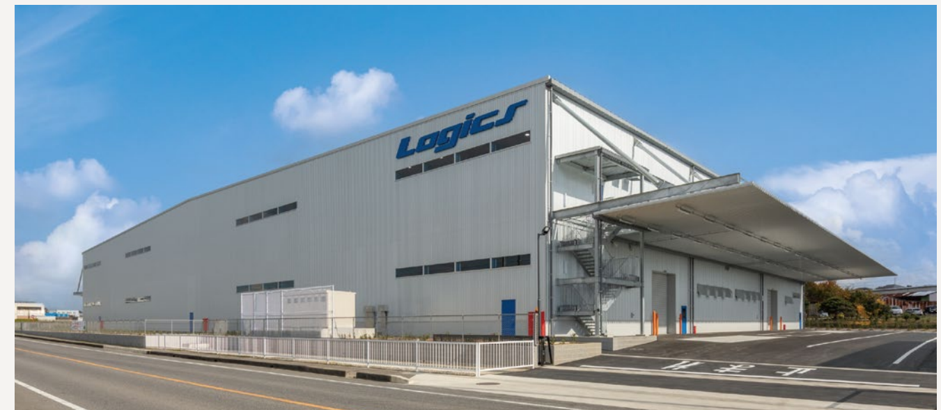
【(株)ロジックス 豊田南物流センター】 S2F 〈倉庫〉建築面積:11,329㎡ 延床面積:20,718㎡ 〈事務所〉建築面積:202㎡ 延床面積:200㎡ 設計:アイシン開発 竣工:2020年
