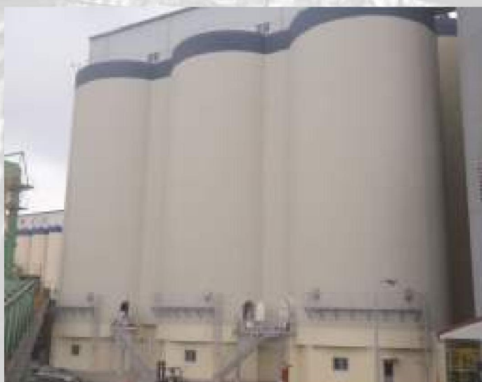
副原料用平底サイロ 1700t×3基
