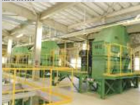
バケットエレベーター
