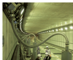
水噴霧設備の点検
