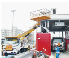
料金所の点検
