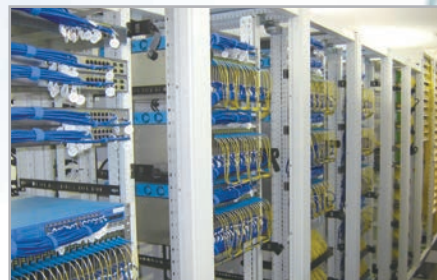
通信機器設置
