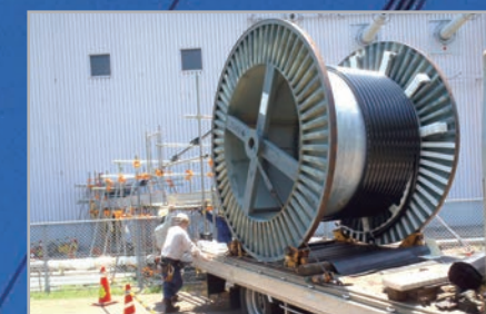
187kV地中送電線 ケーブル張替作業
