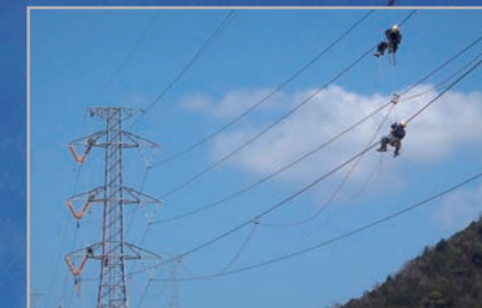
187kV架空送電線 電線張替作業
