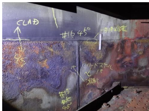
設備メンテナンス(腐食対策)
