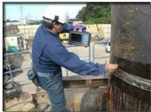
非破壊検査などの検査 結果による寿命評価
