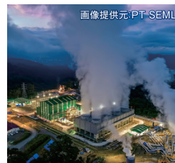
地熱発電設備
