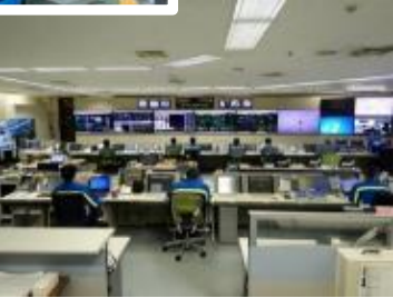
ガス製造 中央制御室 (CCR)
