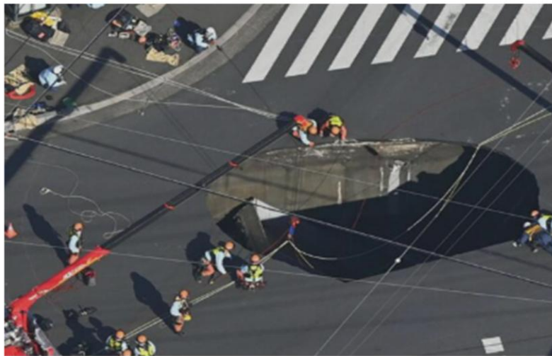
埼玉県八潮市 令和7年1月28日 下水道管老朽化による道路陥没 ※建設後42年経過
