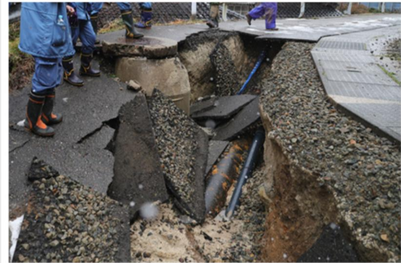
京都市下京区 令和7年4月30日 水道管老朽化による水道管破裂 ※建設後65年経過
