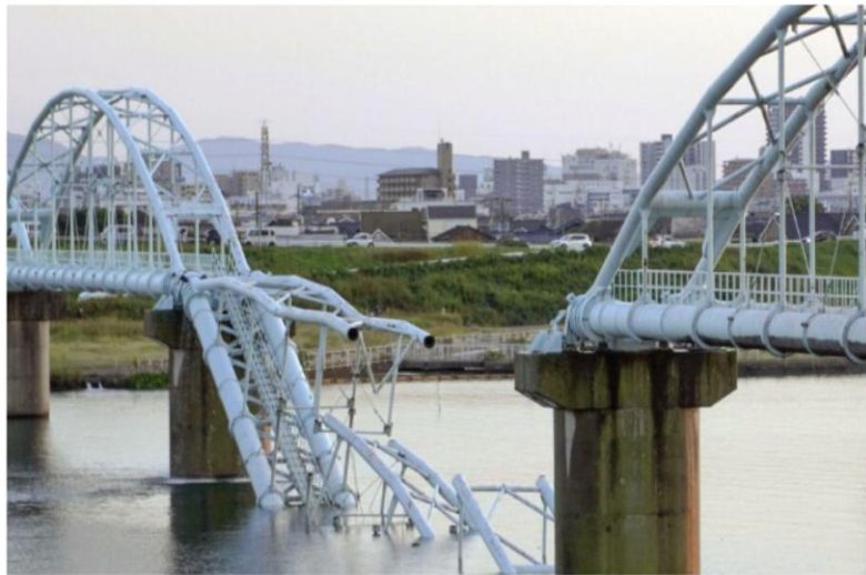
和歌山市「六十谷水管橋」崩落 令和3年10月3日 ※建設後46年経過
