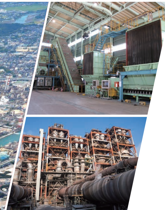
上から、リクレーマ(石炭の払出設備)、低温炭化によりバイオマスの取扱いを容易にしたトレファイドペレット、廃プラスチック処理設備、九州工場苅田第一地区キルン
