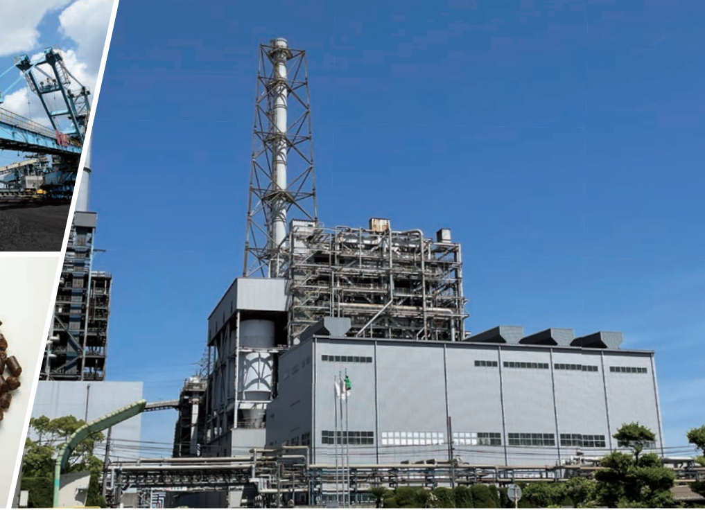
216MW発電設備
