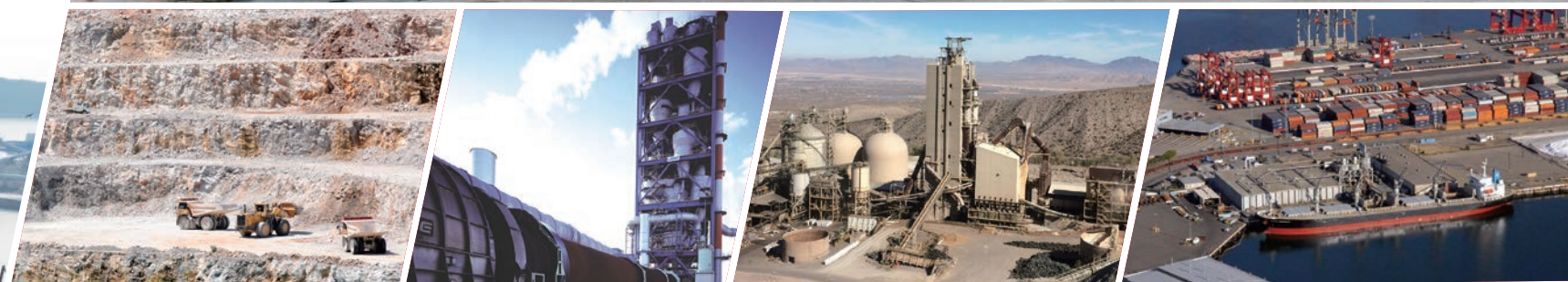
左から、伊佐鉱山、山口工場宇部地区、米国三菱セメント社クッシュンベリー工場、MCCターミナル（ロングビーチ港）
