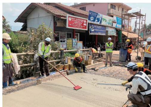
補修工学研究所でのJICA研修 (上)、ラオスでの施工指導 (下)
