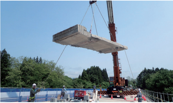
2018年 高速道路リニューアル工事の様子
