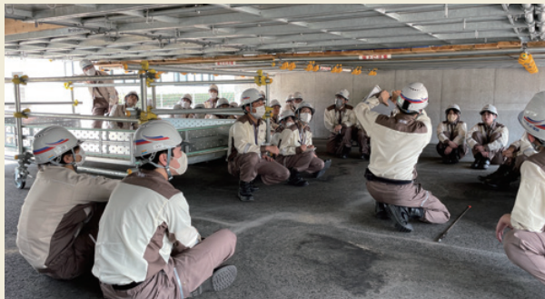
研修用橋梁での足場講習
