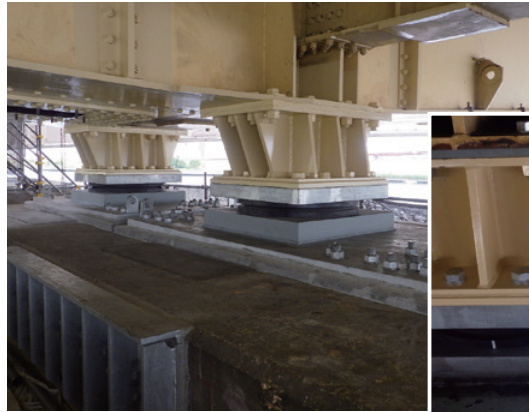
支承受替完了
