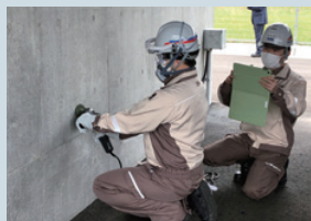
施工写真撮影実習（サンダーでの下地処理）
