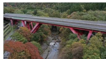
東北自動車道 天狗橋
