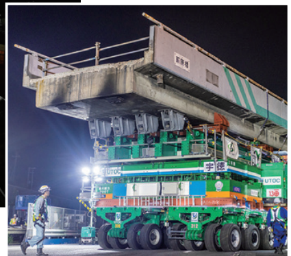
撤去橋梁運搬状況
