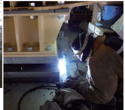
支承受替施工状況
