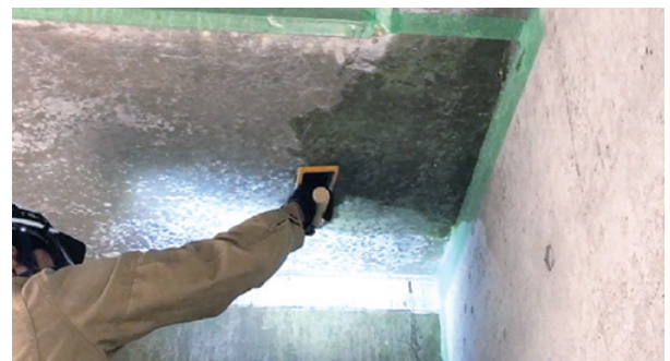
SBLNジェルの施工状況
