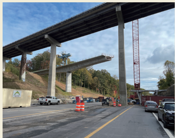
ST社の施工現場
