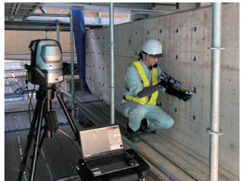
3D計測機を用いたアンカーボルト削孔位置の計測状況
