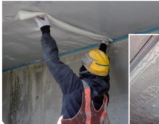
コンクリート片はく落防止シート貼付状況
