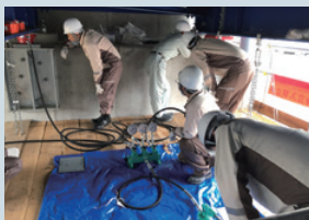
ジャッキアップ実習
