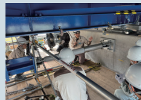
耐震補強装置の施工実習
