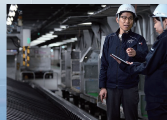
手荷物搬送設備
