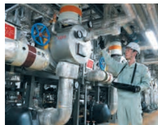
衛生設備点検
