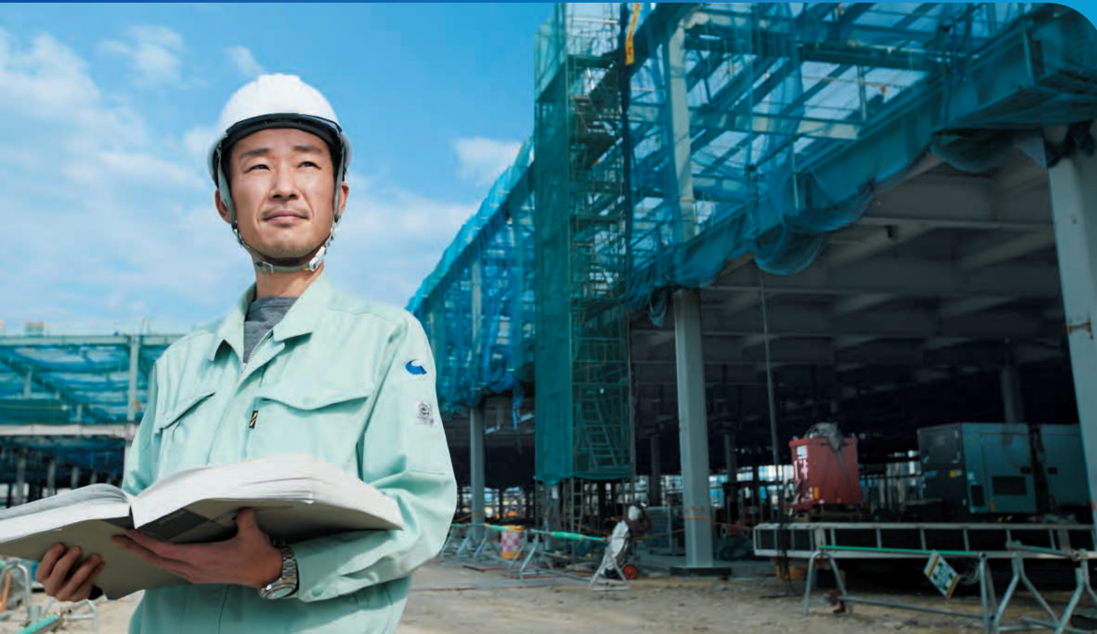
第2ターミナル建設工事
