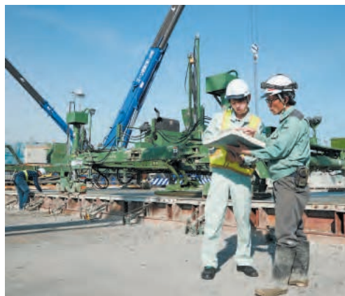
現場指導（エプロン工事）
