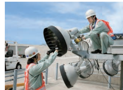
エプロン灯柱点検
