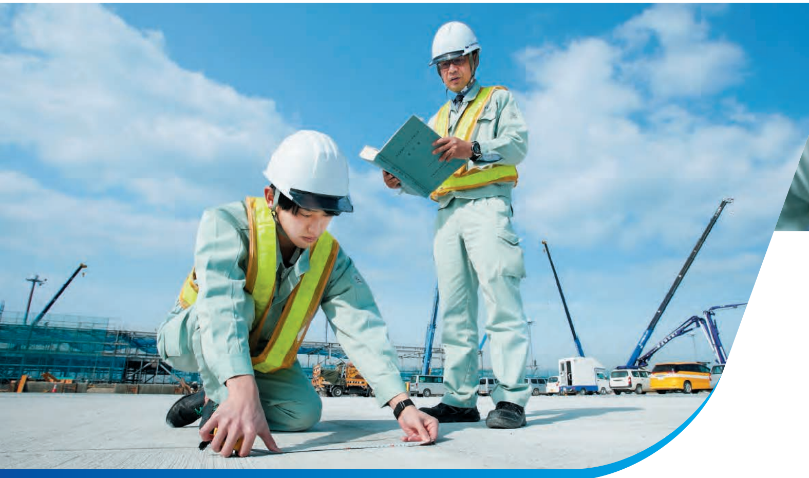
施工管理（エプロン工事）
