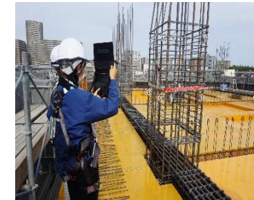
配筋写真撮影
