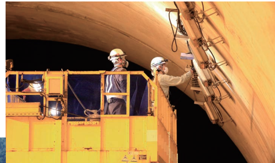
トンネル照明設備点検
