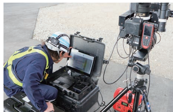
高解像度カメラを用いた構造物の点検
