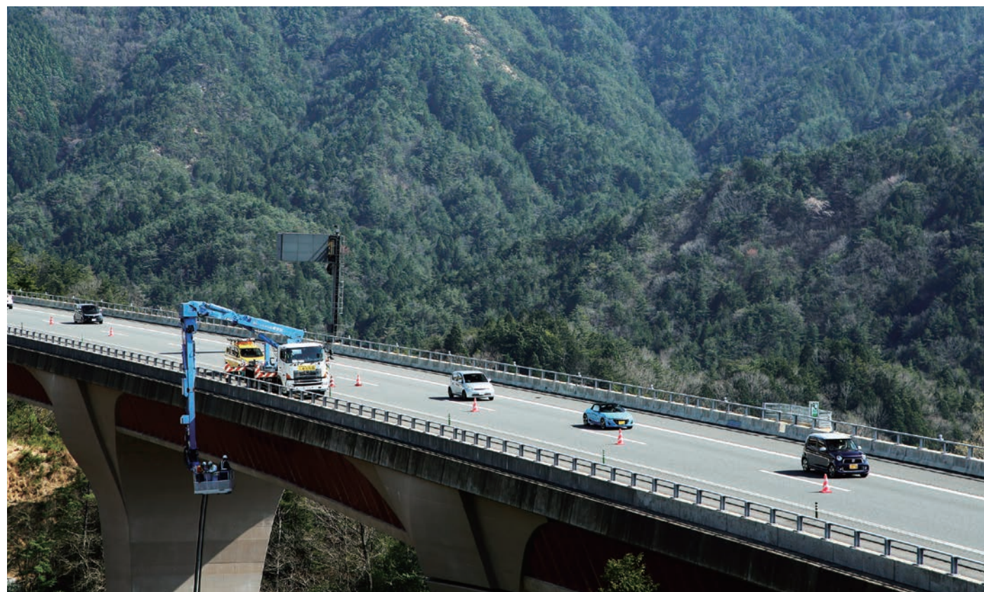
橋梁点検車による橋梁詳細点検
