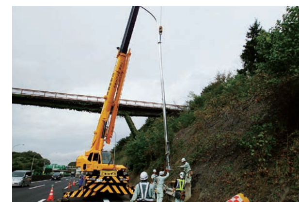
道路照明事故復旧
