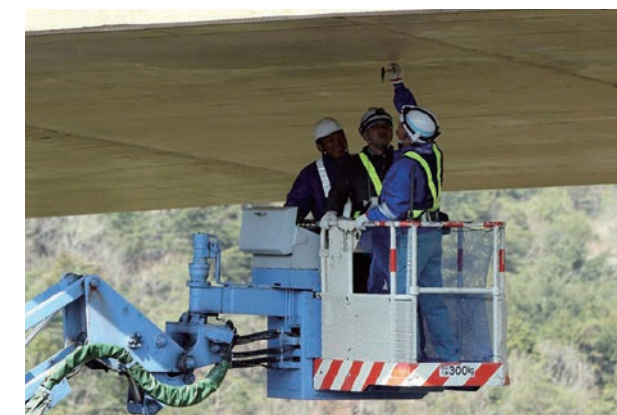
橋梁床版下面の近接目視点検
