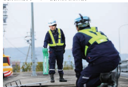
埋設物の探査
