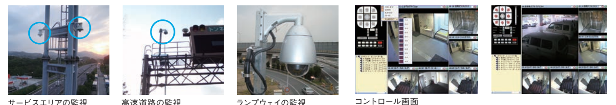
サービスエリアの監視
