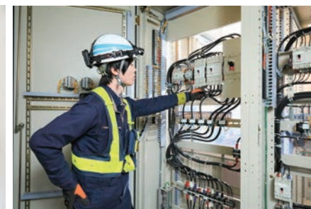
受配電設備の点検
