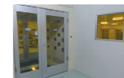
クリーンルーム Clean Room
