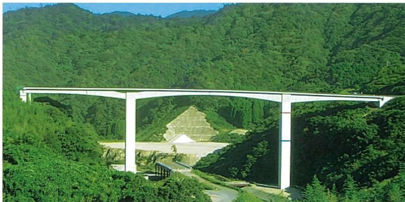
河内橋(大分県) 橋長/285m 3径間連続ラーメン箱桁橋 国土交通省九州地方整備局発注 事務所長表彰受賞
