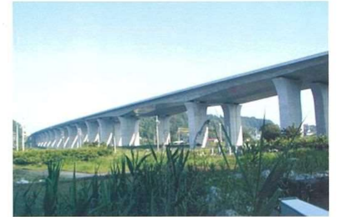
敷地高架橋(静岡県) 橋長/612m PRC(12+5)径間連続中空床版橋・PRC3径間連続箱桁橋 NEXCO中日本静岡建設局発注
