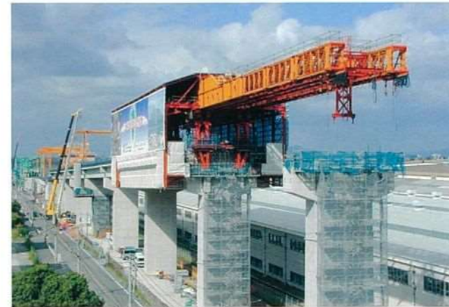
九州新幹線 第二地下道高架橋(福岡県) 橋長/1,080m(内700m) 4主版T桁橋、他単純T桁橋 九州新幹線建設局発注 PC工学会・施工技術賞受賞
