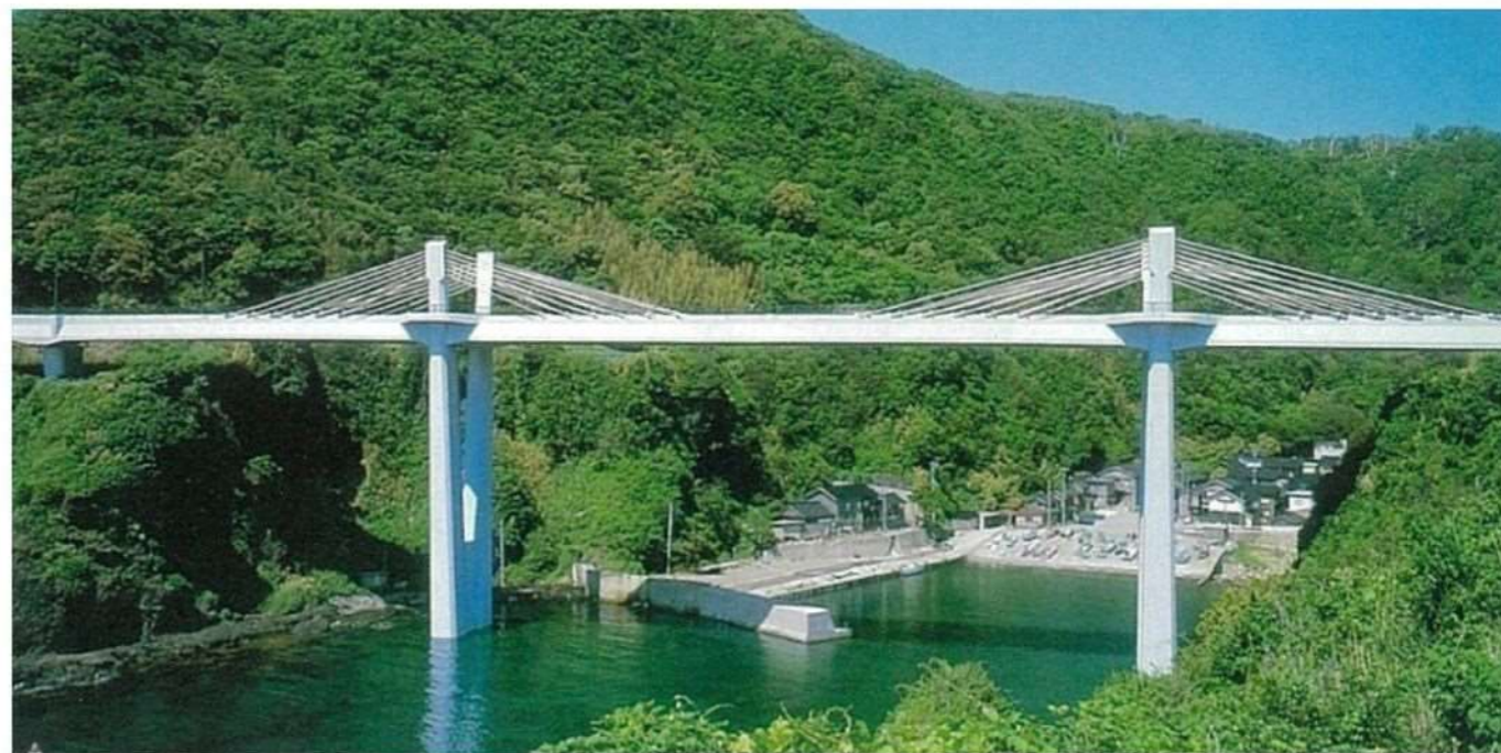
長者ヶ橋(新潟県) 橋長/294m 5径間連続エクストラードズド橋 新潟県発注
