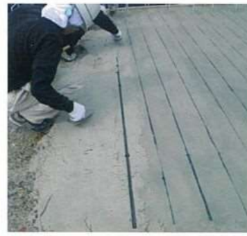
床版の拡幅と上面補強
