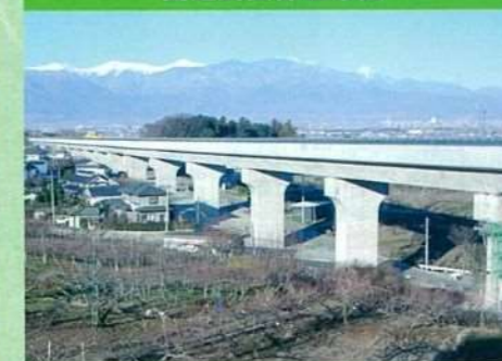
山梨リニア小山高架橋(山梨県)
