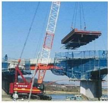
コンクリート桁の一部を鋼桁に取換え
