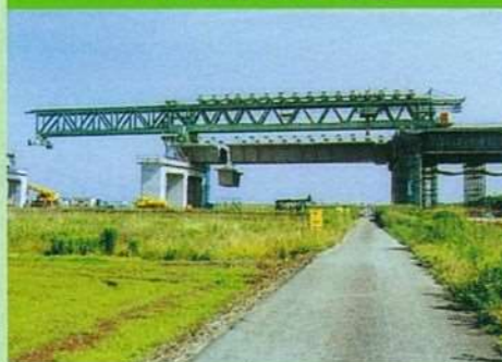
鍋田高架橋(愛知県)
