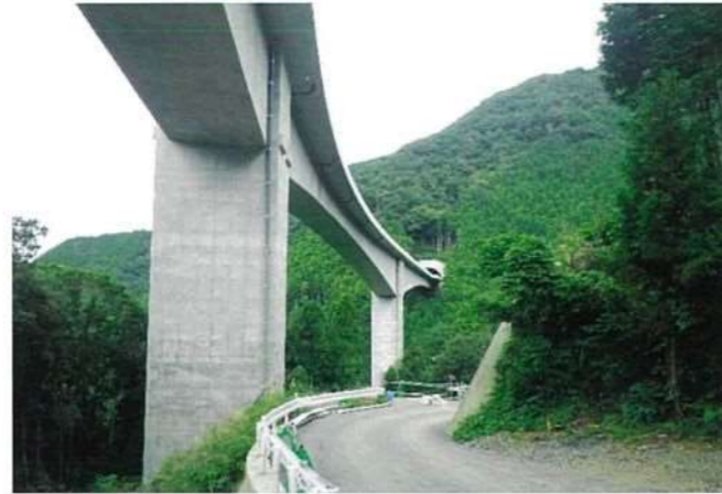
つづら川橋(愛媛県) 橋長/311m 3径間連続ラーメン箱桁橋 国土交通省 四国地方整備局発注 局長表彰受賞
