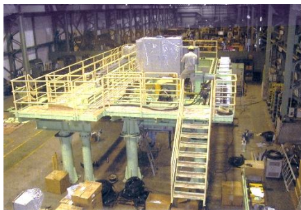
探傷装置製作・据付
