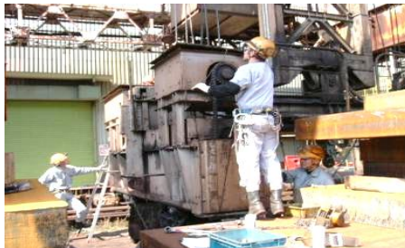
クレーン爪点検
