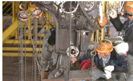
クレーン爪分解整備
