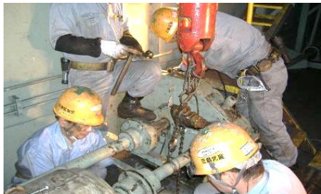
クレーン減速機整備
